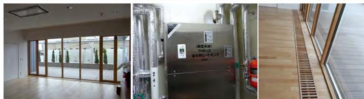
竣工直後のリビングの様子      機械室内の地中熱ヒートポンプ      窓からの冷気を抑えるため、床下に温水パイプが収められている
