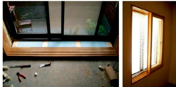
図5 「木枠内窓+ブラインド+金属枠外窓」リフォームの様子(札幌市中央区のマンションの一室(西面))
